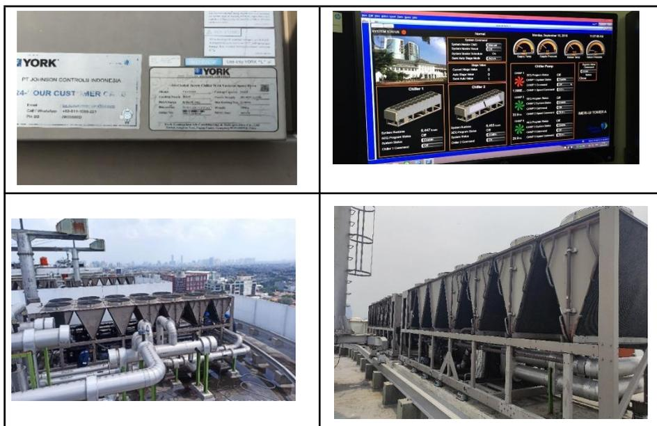
3. Sistem pendingin Gedung H dengan menggunakan chiller dan VRV untuk area Laboratorium (setelah dilakukan renovasi). AC split di FKUI sudah mulai beralih ke R32 secara bertahap dengan mengganti yang rusak ke AC dengan R32.
