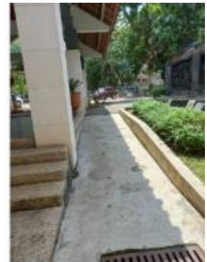
Selasar selatan Gedung II
