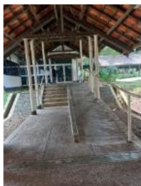
Gedung IV menuju Gedung III
