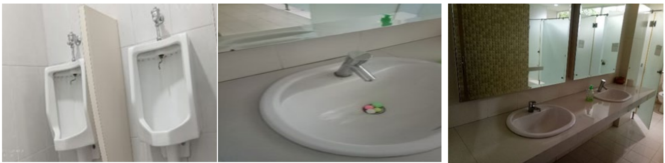
Gedung II lantai 4
