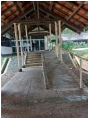
Gedung IV menuju Gedung III
