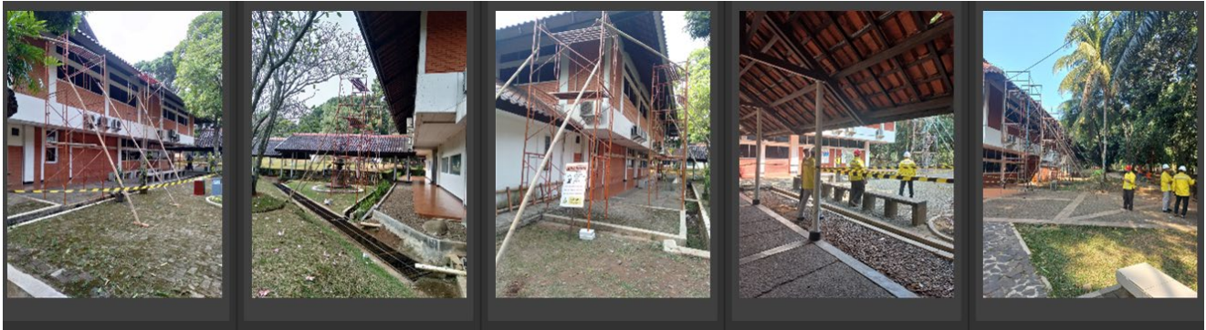
Renovasi atap gedung V dan VI
