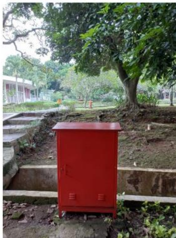
Taman belakang Gedung VII
