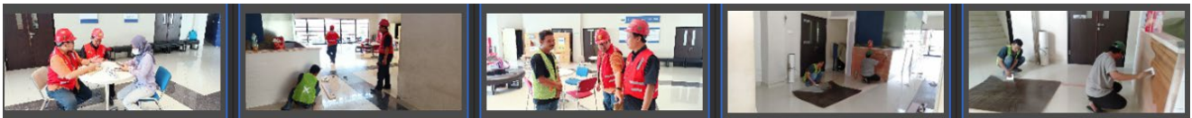
Renovasi ruang kerja LBI (gedung X)
