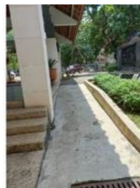
Selasar selatan Gedung II
