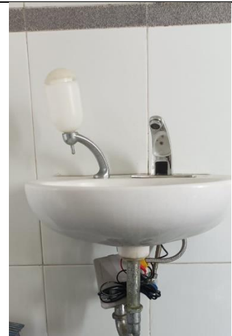
Kran wastafel setelah di ganti dengan kran sensor.
