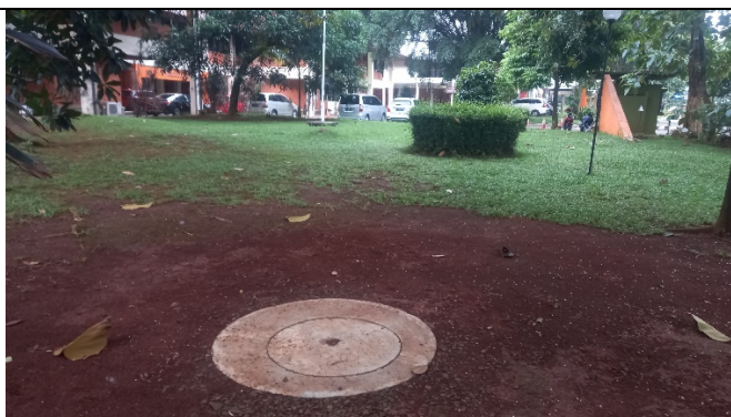
Sumur Resapan di area Taman Fisip
