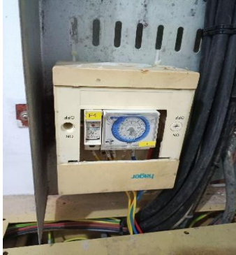
Timer Otomatis Exhaust Fan Basement Gedung IMERI
