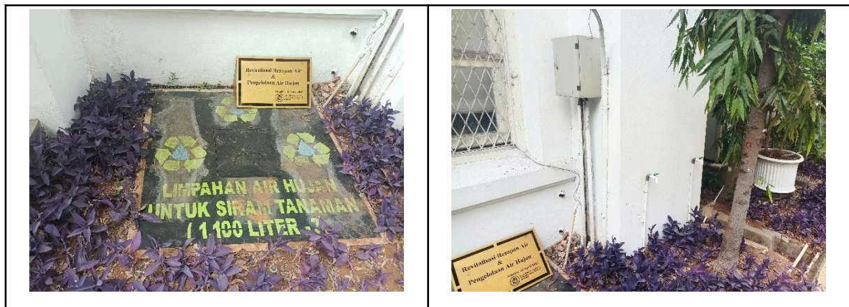
Bak Penampungan Air AC Gedung H FKUI jadi satu dengan Bak Penampungan Air Hujan
