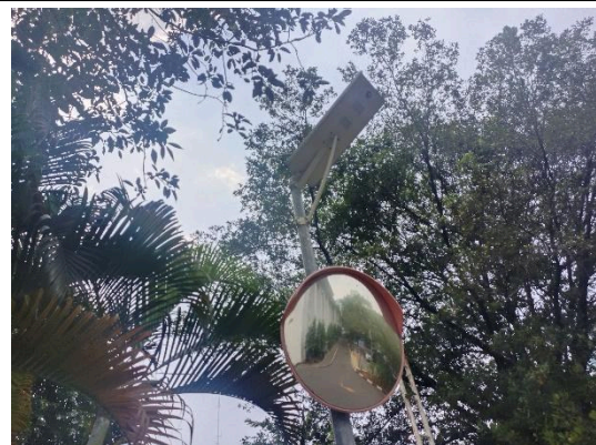
PLTS untuk Penerangan Jalan Berbasis Sensor Cahaya
